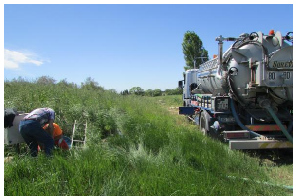
Photo prise le 28/04/16 – Curage du poste N°2
