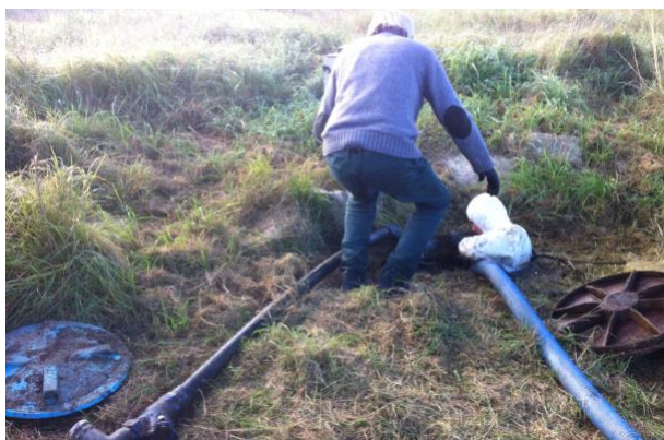
Photo prise le 17/11/15 – Remplacement pompe N°2
