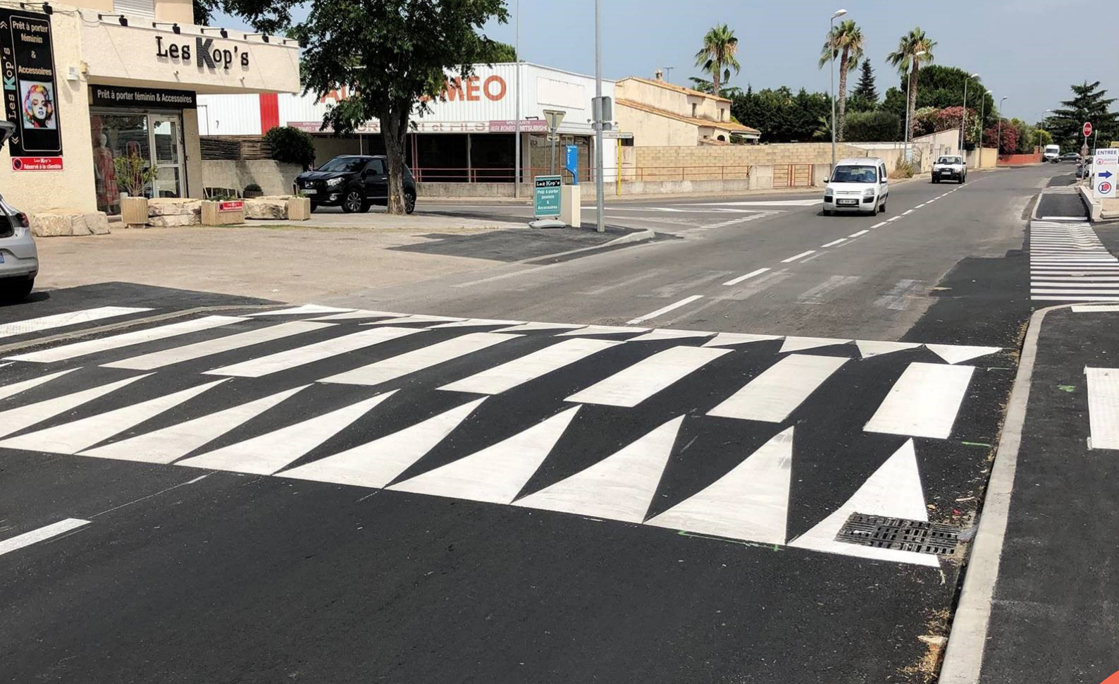
Entretien route et création passage piéton sécurisé rue du Levant
