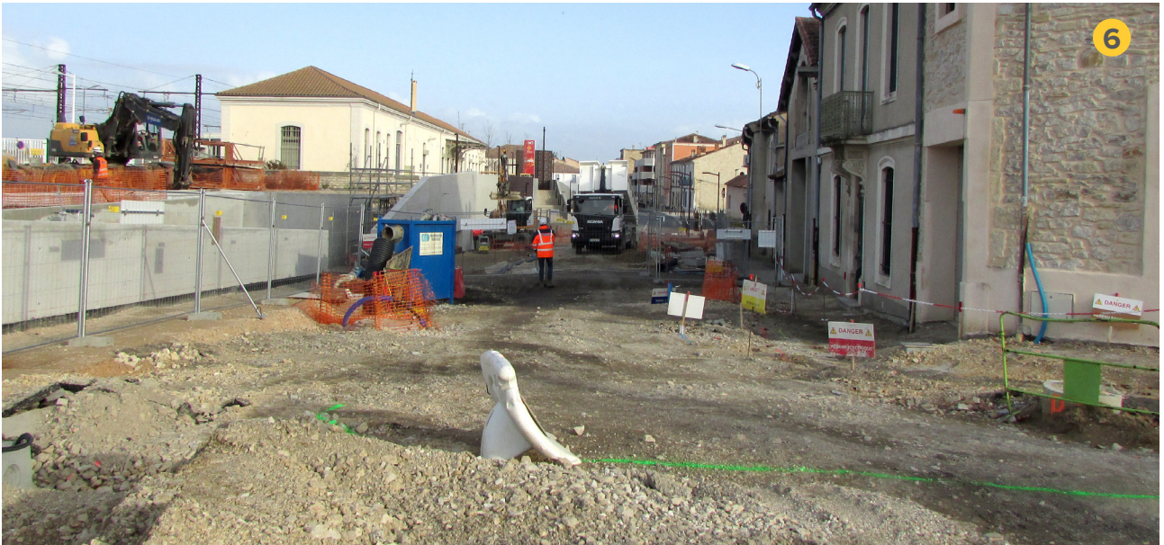
4 Pose des murs de soutènement sur la rue de Verdun. 5 Travaux sur les réseaux sur le carrefour Verdun/Gambetta. 6 Réfection des trottoirs et des réseaux le long de la rue de Verdun
