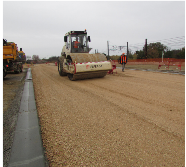
Pose des bordures et caniveaux, réglage de la plateforme avec sous-couche GNT
