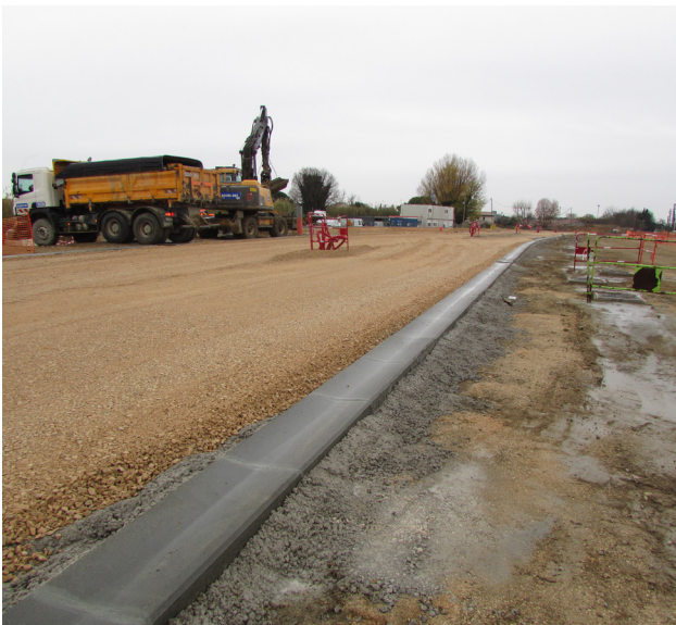
Pose des bordures et caniveaux, réglage de la plateforme avec sous-couche GNT
