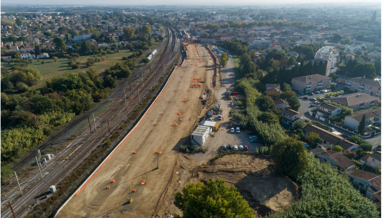
Vue aérienne du parking sud
