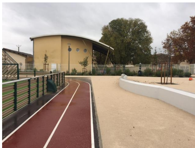
Bâtiment maternelle (vue coté terrain multisport)
